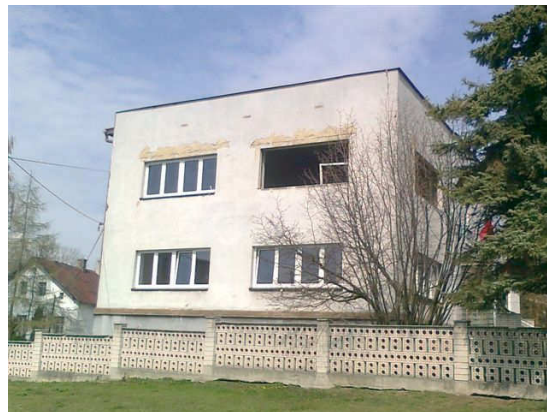
Obr. Výměna oken na Obecním úřadě v Sudicích
